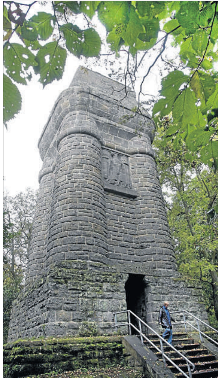
Bismarckturm kann wieder besucht werden: Auf der neuen Treppe kommen die Besucher sicher bis zur Turmspitze. Foto: Herzog
